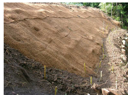
Berge après travaux
